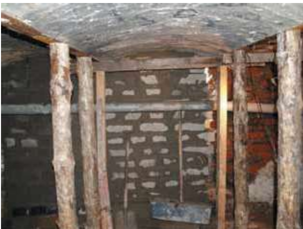
Rys. 8. Podparcie stropu na czas wykonywanych robót
