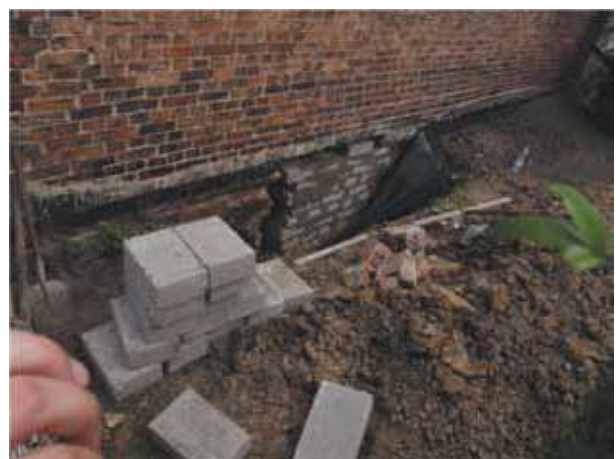
Rys. 9. Widok na fragment odbudowanej ściany
