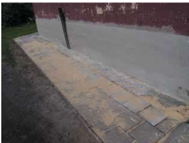
Rys. 13. Demontaż części chodnika betonowego przy uszkodzonej ścianie
