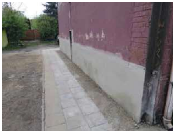
Rys. 16. Widok ściany po naprawie
