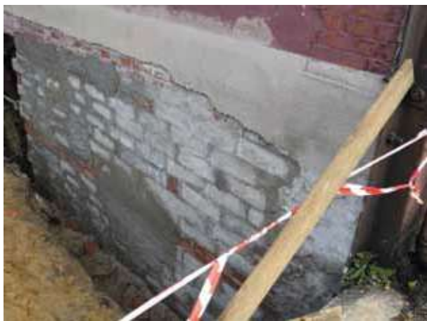
Rys. 15. Rekonstrukcja uszkodzonej ściany szczytowej budynku
