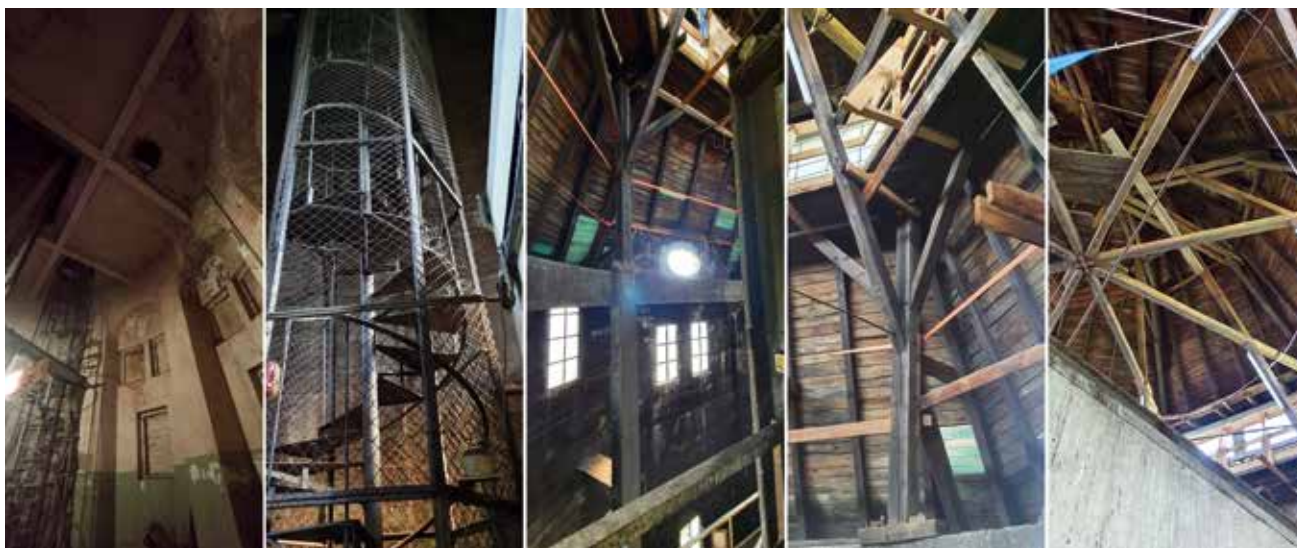
Fot. 3. Wnętrze wieży „Borki” – arkadowe rozczłonkowanie ścian kondygnacji parteru, zachowana stalowa, spiralnie kręcona klatka schodowa, wnętrze tamburu, wyremontowana drewniana więźba dachowa; źródło: (fot. aut.)
