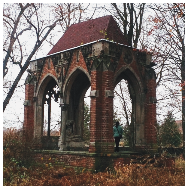
Il. 9. Widok zespołu mauzoleum w Jałowcu. Stan z 2015 r. (fot. S. Wróblewski)
