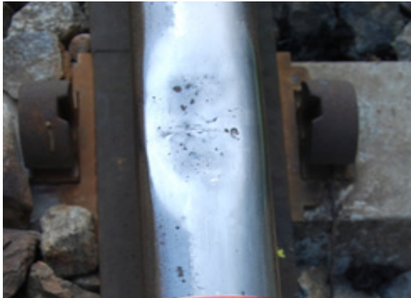
Rys. 11. Widok plastycznej deformacji szyny spowodowanej uderzeniem koła kolejowego
