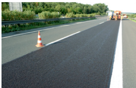
Fot. 33. Końcowy efekt na autostradzie [2] (zabieg na pojedynczym pasie ruchu)
