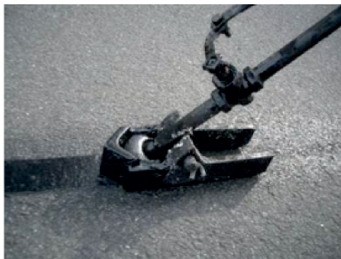
Fot. 7. Uszczelnianie, wyfrezowanej w miejscu pęknięcia nawierzchni, komory wypełnienia zalewą asfaltowo-kauczukową (BIGUMA TL 82) rozprowadzaną (na gorąco) przy pomocy lancy z tzw. „ruchomym butem” [1]
