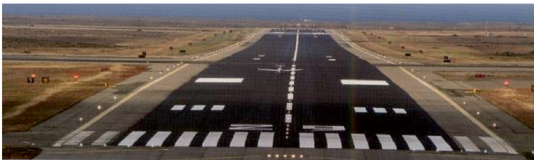
Fot. 22. Widok nawierzchni drogi startowej po wykonanym zabiegu konserwacji środkiem Rhinophalt® [2]
