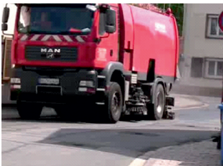
Fot. 24. Oczyszczanie nawierzchni wodą pod ciśnieniem wraz z odsysaniem szlamu [2]
