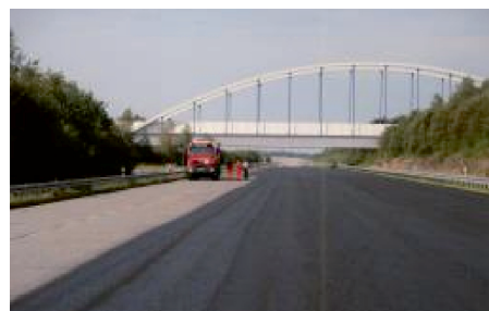
Fot. 20. Widok nawierzchni drogowej w trakcie wykonywania zabiegu konserwacji [2]
