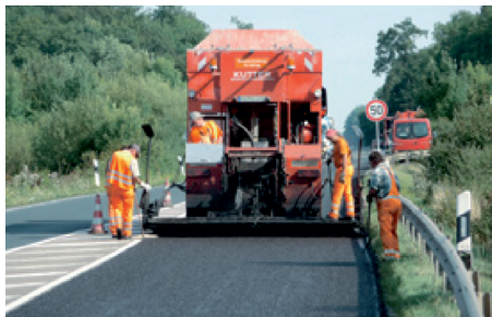
Fot. 31. Wykonywanie cienkiej warstwy z użyciem emulsji asfaltowej [2]
