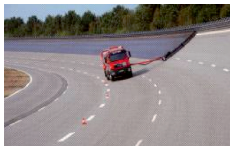
Fot. 21. Widok nawierzchni asfaltowej na torze do testowania samochodów w trakcie zabiegu konserwacji [2]
