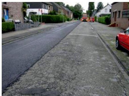
Fot. 25. Wbudowywanie cienkiej warstwy ochronnej w terenie zabudowanym [2]
