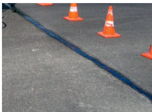
Fot. 7. Uszczelnianie, wyfrezowanej w miejscu pęknięcia nawierzchni, komory wypełnienia zalewą asfaltowo-kauczukową (BIGUMA TL 82) rozprowadzaną (na gorąco) przy pomocy lancy z tzw. „ruchomym butem” [1]
