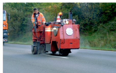
Fot. 29. Usuwanie oznakowania poziomego z nawierzchni w obszarze niezabudowanym [2]
