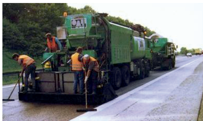
Fot. 23. Zestaw maszyn do wykonywania cienkiej warstwy ochronnej [1]
