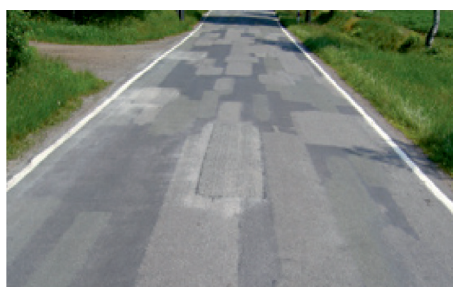
Fot. 28. Przykładowy stan istniejącej nawierzchni w obszarze niezabudowanym [2]
