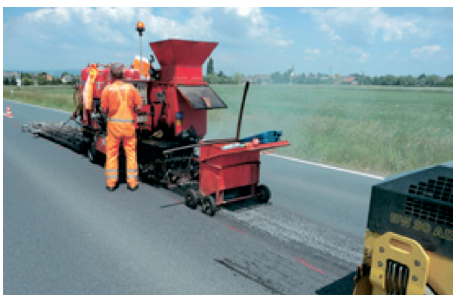
Fot. 12. Widok maszyny wykonującej zabieg uszczelnienia metodą remixingu połączeń technologicznych [2]
