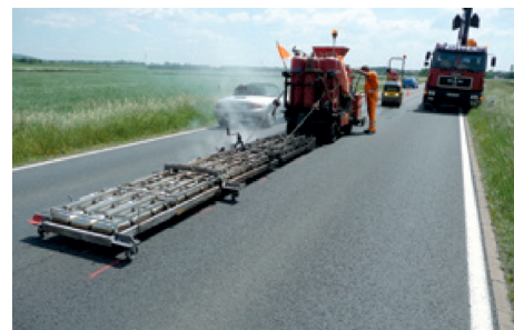
Fot. 11. Widok promiennika podczerwieni, którym podgrzewana jest nawierzchnia w obszarze uszkodzenia [2]
