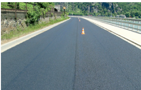
Fot. 32. Końcowy efekt na drodze w obszarze niezabudowanym [2]
