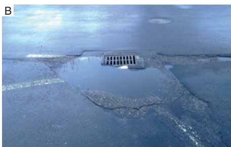
Fot. 34. Przykłady „klasycznie” wykonywanych napraw miejscowych (strona lewa – A, B) oraz przykłady napraw miejscowych (strona prawa – C, D), wykonywanych z wykorzystaniem technologii Mikropok MA [1]
