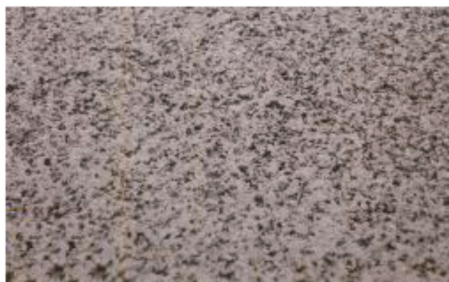
Fot. 18. Widok nawierzchni drogowej po wykonaniu zabiegu konserwacji [2]
