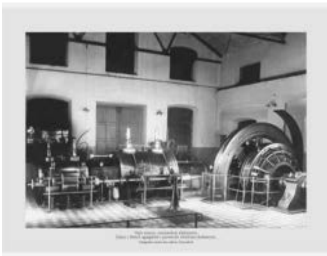
Rys. 5. Hala maszyn rzeszowskiej elektrowni. Jeden z dwóch agregatów z parowymi silnikami i okowymi
