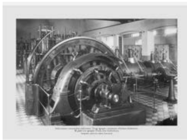
Rys. 3. Hala maszyn rzeszowskiej elektrowni. Agregat i maszyna z parowymi silnikami t okowymi
