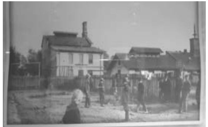
Rys. 1. Budynek Gazowni Miejskiej, pierwsze lata XX wieku
