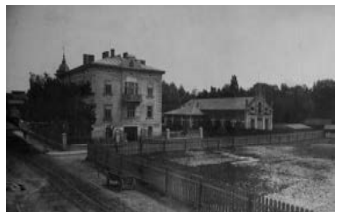
Rys. 2. Budynek Dyrekcji i Administracji Gazowni Miejskiej i Elektrowni, w głębi budynek elektrowni przed rozbudową 1914 r.
