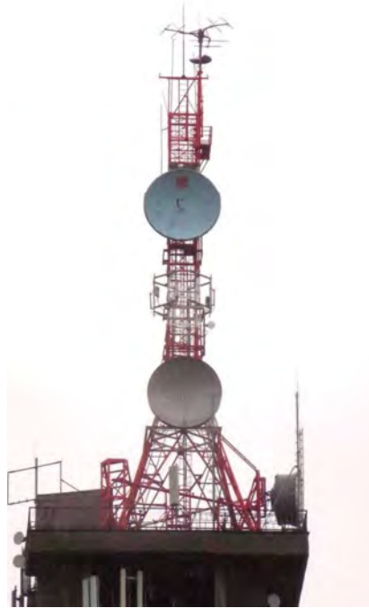
Rys. 1. Konstrukcja wieży stalowej posadowiona na wieży żelbetowej
