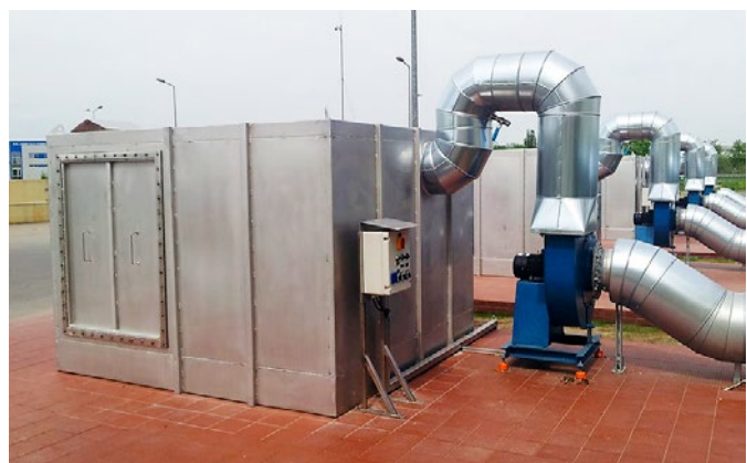
Filtry świecowe z adsorbentem z węgla aktywnego
