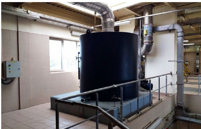
Adsorber z węgla aktywnego na kratkach gęstych
