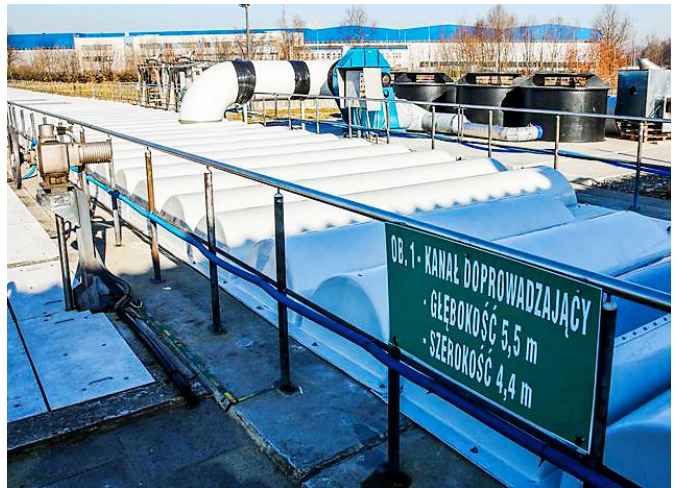
Hermetyzacja kolektora płaszowskiego doprowadzającego ścieki
