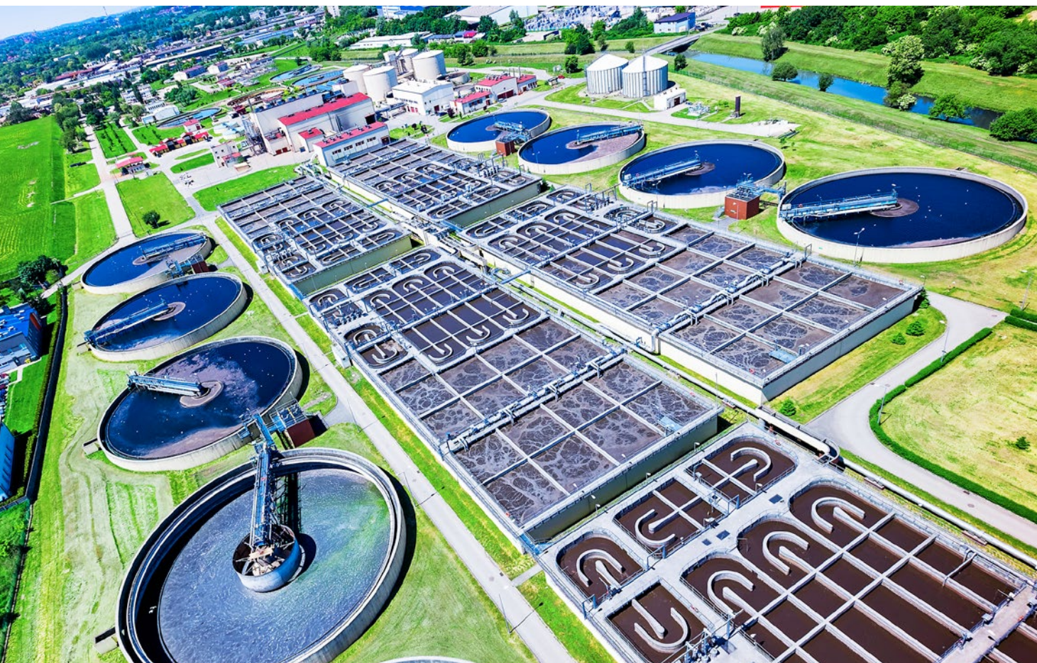
Oczyszczalnia ścieków Płaszów
