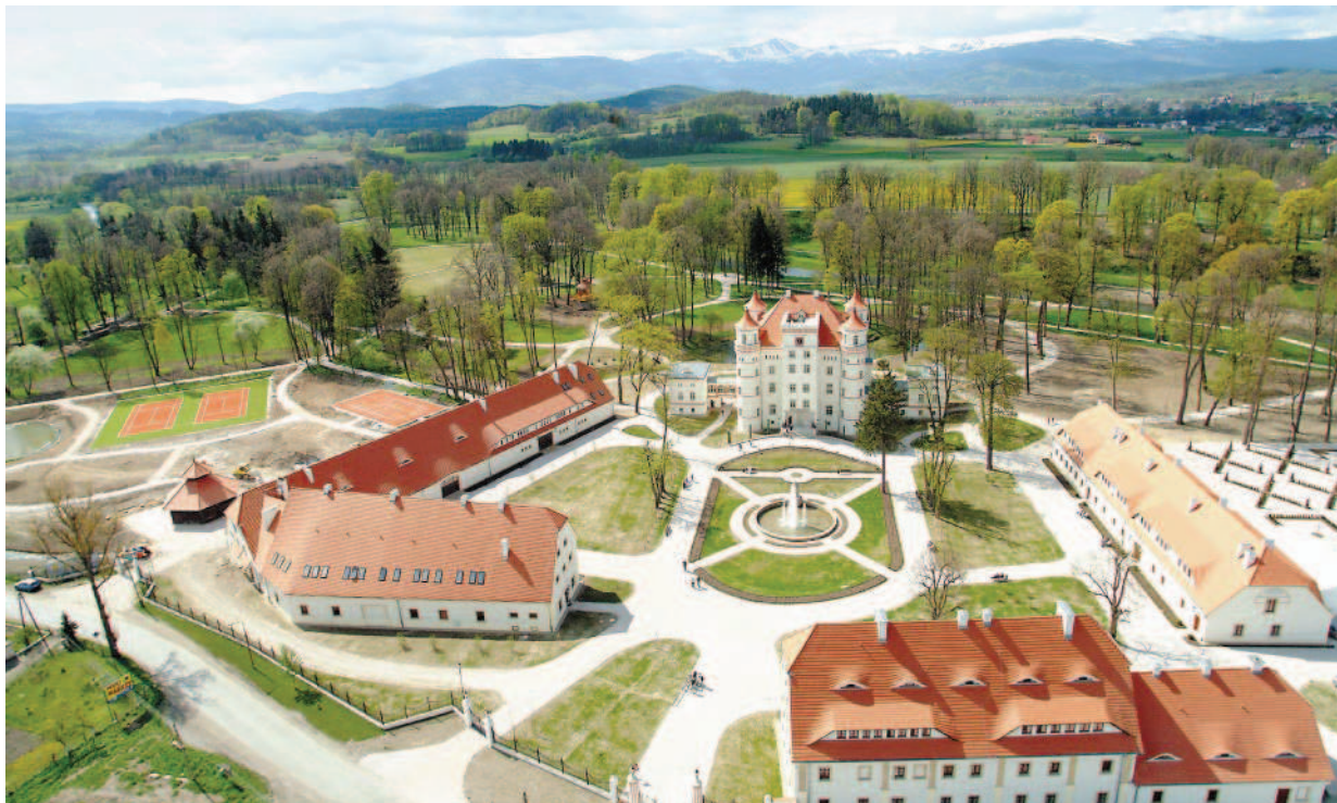
Ryc. 4. Wojanów, widok z lotu ptaka na zespół pałacowy po rewaloryzacji Fig. 4. Wojanów, a bird's eye view of the palace complex after restoration
