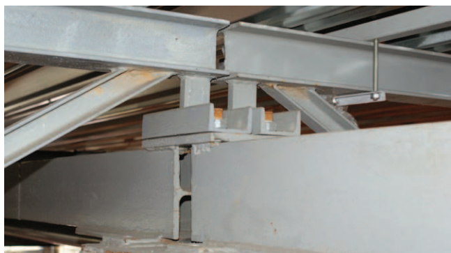
Rys. 5. Oparcie płatwi na dźwigarze głównym
