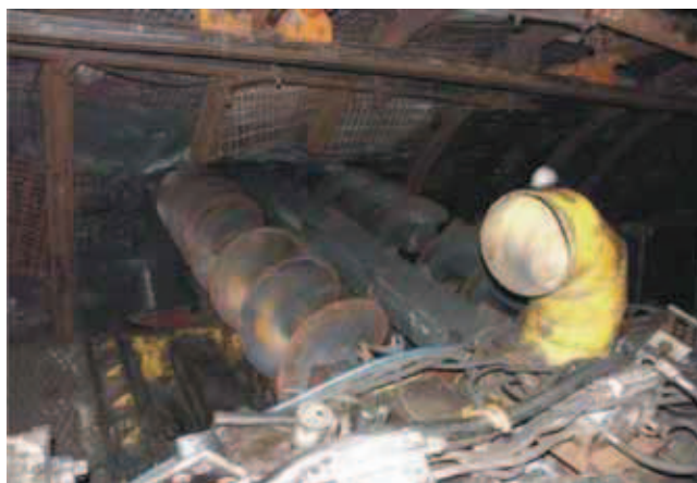
Rys. 7. Widok wiertel wielkośrednicowych wraz z przewodem do doprowadzenia świeżego powietrze [5] Fig. 7. View of large diameter boreholes with the supply conduit of fresh air [5]
