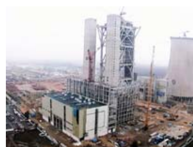
Budowa nowego bloku 858 MW (2008 r.)
