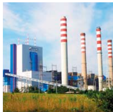
Elektrownia „Pątnów”. Widok bloku „Pątnów II” z nowymi kominami IOS „Pątnów I”
