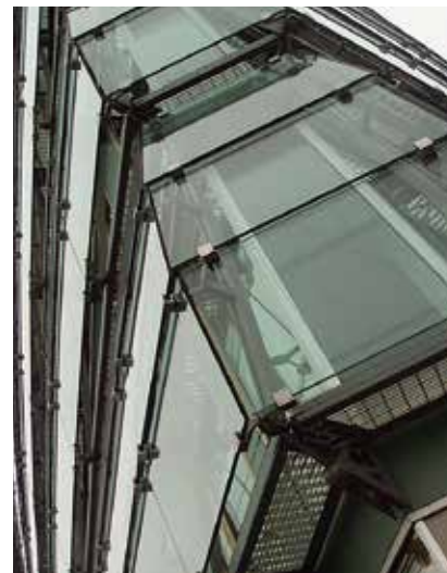
Rys. 4: a) przykład nieszczelnej drugiej fasady wykonanej z jednowarstwowej szyby bezpiecznej (budynek Nanotechnologii ZUT w Szczecinie, arch. Studio A4 Szczecin), b) budynek biurowy w Berlinie; źródło – zdjęcia autora
