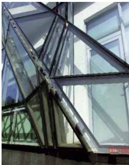
Rys. 4: a) przykład nieszczelnej drugiej fasady wykonanej z jednowarstwowej szyby bezpiecznej (budynek Nanotechnologii ZUT w Szczecinie, arch. Studio A4 Szczecin), b) budynek biurowy w Berlinie; źródło – zdjęcia autora
