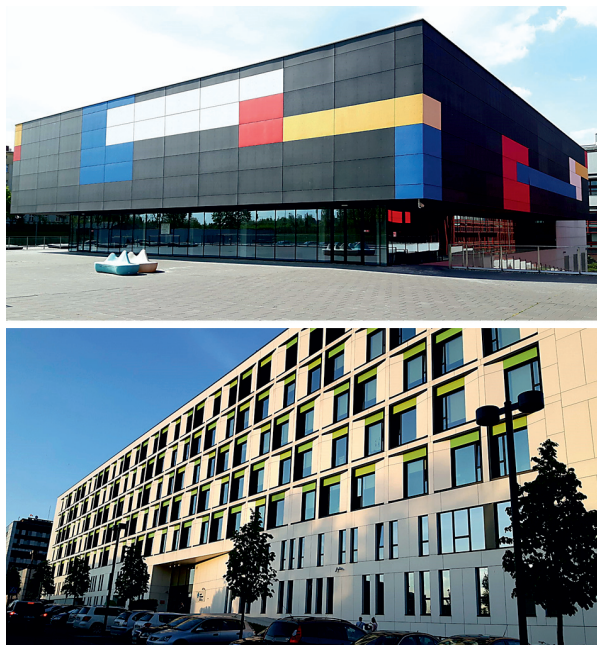
Rys. 1. Widok przykładowych elewacji wykonanych z wykorzystaniem płyt włóknisto-cementowych na budynkach użyteczności publicznej
