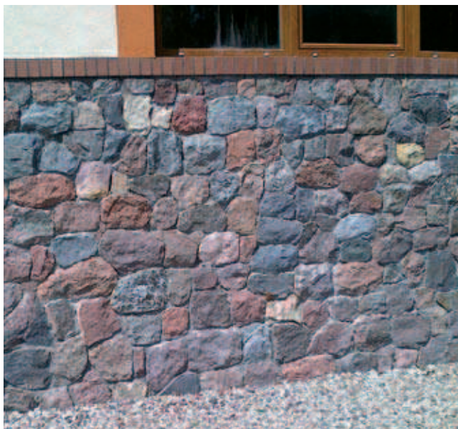
Fot. 1. Przykład różnorodności kamienia naturalnego w jednym murze (fot. R. Jarmontowicz)
