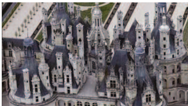
Rys. 10. Chambord (Francja) początek XVI w.: a) widok dachu z góry [9], b) brak rynien w okapach dachów i rzygacze oraz rury spustowe odprowadzające wodę z tarasu [10]
