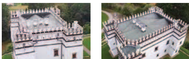
Rys. 1. Kasztel w Szymbarku: a) przelewy przez attykę, b) widoczne spadki dachu stromego [2]
