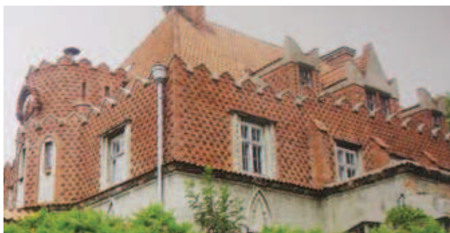
Rys. 8. Dwór w Czechnowie – rury spustowe na ścianach szczytowych [8]
