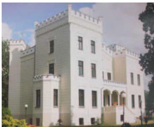
Rys. 9. Rury spustowe odprowadzające wodę z dachu i z tarasu wkomponowane w architekturę [8]
