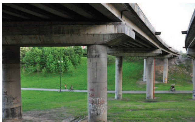
Fot. 1. Wiadukt lewy. Źródło: Protechnicon [8]
