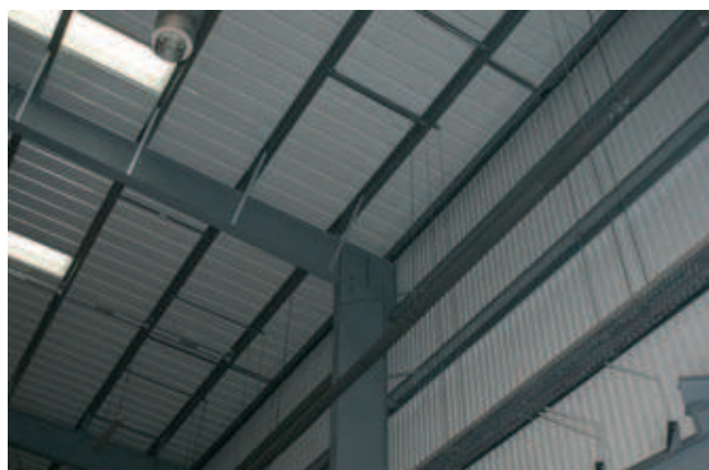
Rys. 2. Widok hali, sztywne połączenie słupa z fundamentem, słup wewnętrzny, połączenie ram poprzecznych z podłużnymi, skrajny słup połączony z ryglem
