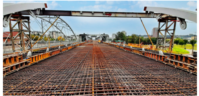
Ryc. 11. Zbrojenie płyty UN w przęśle P3-P4 wraz z zamontowanymi blachami wieszaków, fot. W. Ostrzołek
