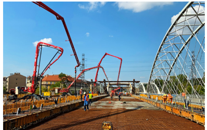
Ryc. 13. Betonowanie płyty ustroju niosącego przęśla P2-P3, fot. M. Franik
