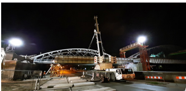
Ryc. 5. Demontaż konstrukcji stalowej istniejącego mostu nad ul. Podgórską, fot. W. Ostrzołek
