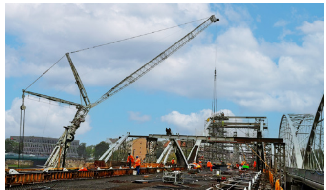
Ryc. 16. Montaż elementów łuku konstrukcji stalowej przęśła nurtowego, fot. W. Ostrzolek
