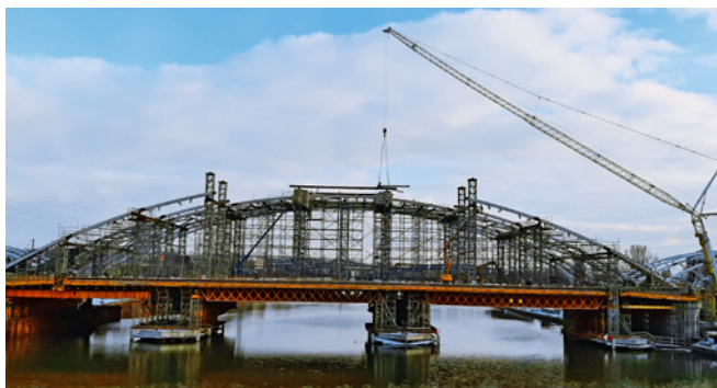
Ryc. 15. Montaż stężeń konstrukcji stalowej przęśła nurtowego, fot. W. Ostrzolek
