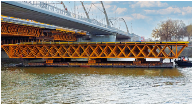
Ryc. 18. Dźwigi kratowe opuszczone na zestaw pontonów, fot. W. Ostrzołek
