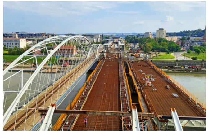
Ryc. 12. Płyta ustroju niosącego przęśla P2-P3 przed betonowaniem, fot. M. Franik
