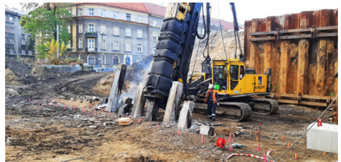
Ryc. 6. Pograżanie pali prefabrykowanych na podporze P1, fot. W. Ostrzołek
