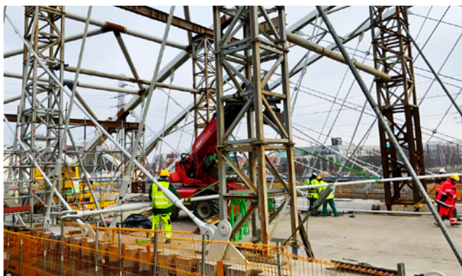
Ryc. 19. Wieszaki w trakcie montażu, fot. W. Ostrzołek
