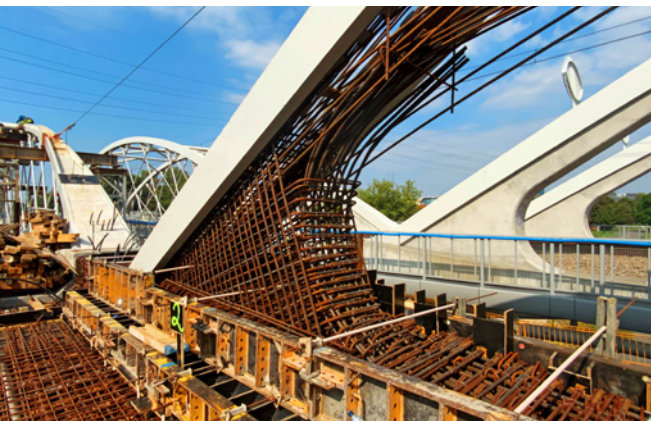
Ryc. 10. Zbrojenie wezłowski, fot. M. Franik
