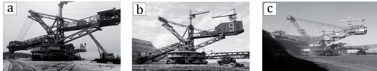
Fig. 11. Excavators a) KWK 1500.1, b) KWK 1500, c) KWK 1200
