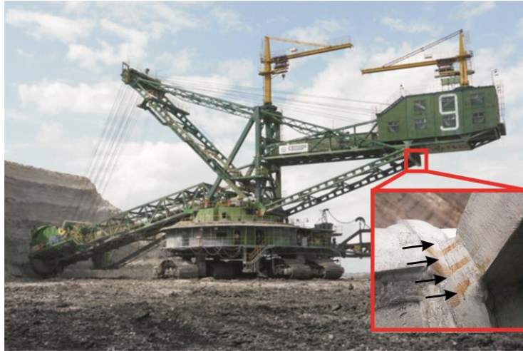
Fig. 1 Rozwijające się pęknięcia zmęczeniowe
