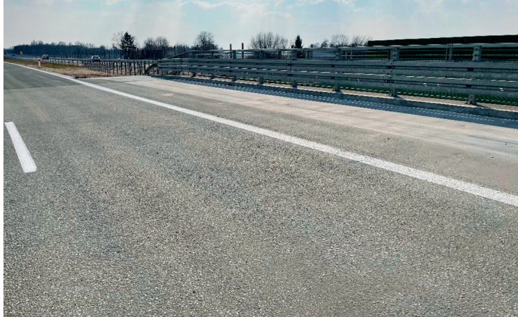
Rys. 2. Etapy wykonania żelbetowej płyty pomostu bez nawierzchni: e) docelowa tekstura płyty po śrutowaniu
