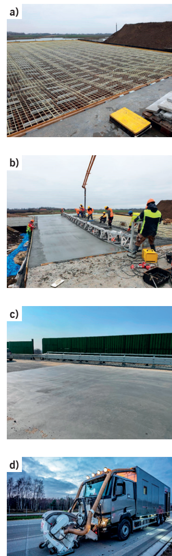
Rys. 2. Etapy wykonania żelbetowej płyty pomostu bez nawierzchni: a) kompozytowe zbrojenie nawierzchni b) betonowanie płyty c) gotowa płyta pomostu d) śrutowanie powierzchni
