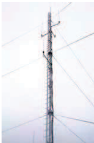
Rys. 6. Maszt o trzonie stalowym rurowym o wysokości 16 m; maszt wyposażony w drabinkę SOLL; osadzenie masztu w miejscu masztu aluminiowego pokazanego na rysunku 5 (fot. archiwum autora)
