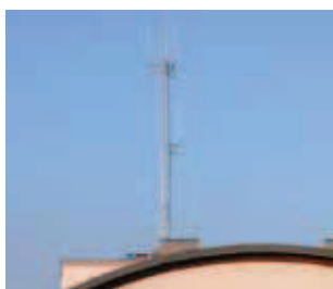
Rys. 4. Przykład masztu o trzonie aluminiowym o wysokości 16 m i linach stalowych \varnothing=3 mm firmy P.W.K POLBIT (fot. archiwum autora)
