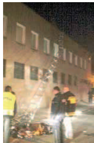
Rys. 8. Przykład katastrofy masztu antenowego typu NET.MASZTY o trzonie aluminiowym wysokości 30 m i linach stalowych \varnothing=3 mm; zdarzenie 18.10.2010 r.; śmierć 2 osób (fot. www.woclawek.info.pl)
