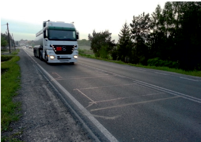
Fot. 1. System WIM z czujnikami wbudowanymi w nawierzchnię jezdni (fot. Autor)
