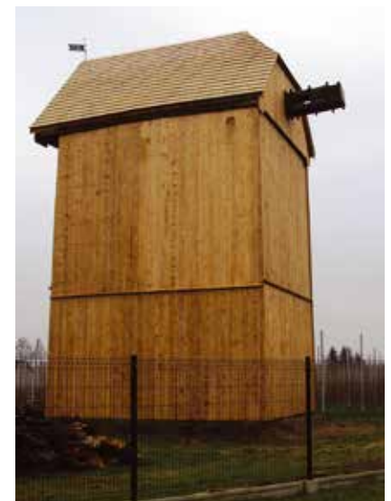
Fot. 3. Wiatrak koźlak w m. Linin, gm. Góra Kalwaria, widok ogólny obiektu po przeprowadzonych pracach remontowych; źródło: fot. F. Tomaszewski, listopad 2022 r.
