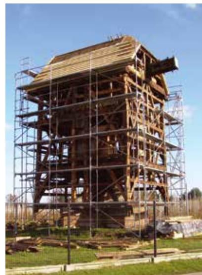
Fot. 2. Wiatrak koźlak w m. Linin, gm. Góra Kalwaria, widok ogólny obiektu w trakcie prac remontowych; źródło: fot. F. Tomaszewski, listopad 2022 r.
