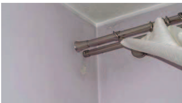
Rys. 9. Zalania w lokalach pod tarasami
