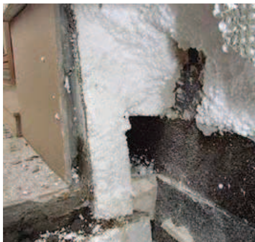
Rys. 11. Odkrywka warstw tarasowych w strefie przyściennej
