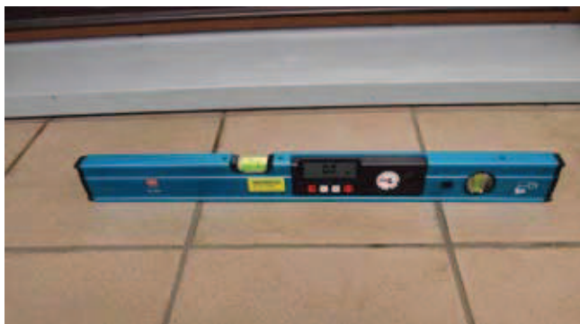
Rys. 2. Posadzka tarasu bez spadków. Wada wykonawcza
