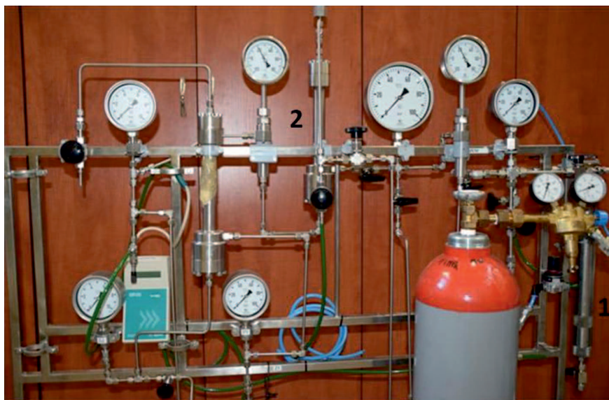
Rys. 3. Zdjęcia laboratoryjnej instalacji do separacji gazów: 1 – filtrseparator, 2 – moduł membranowy
