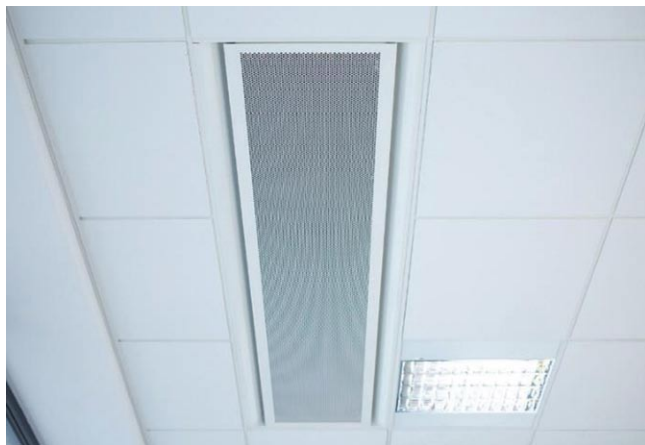
Rys. 7. Nowoczesny system belek chłodzących
