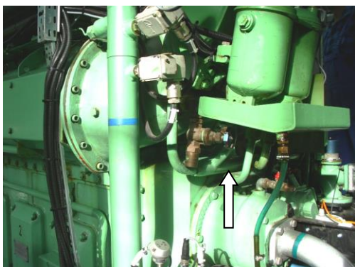
Rys. 2. Zawór upustowy powietrza pomiędzy sprężarką a chłodnicą [źródło własne]
