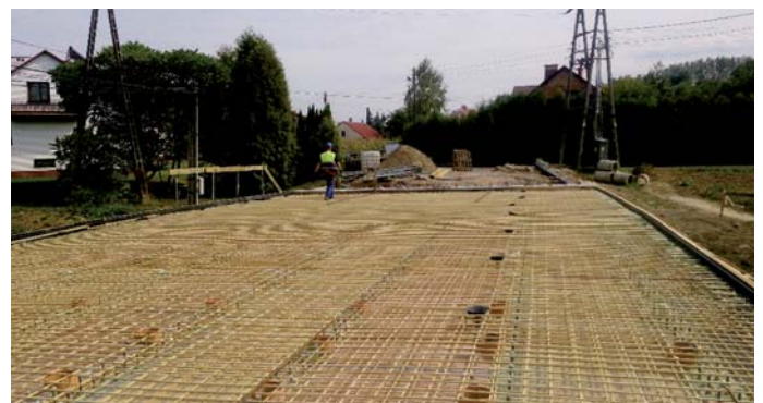
Fot. 9. Zbrojenie betonowej płyty pomostu z prętów kompozytowych
