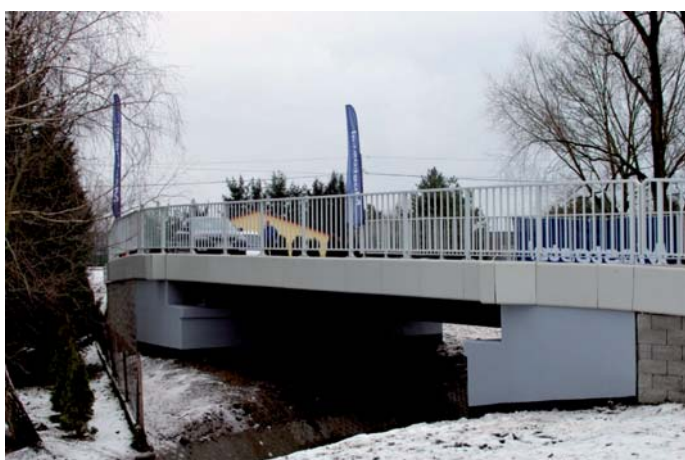
Fot. 4. Most drogowy o konstrukcji kompozytowej w Nowej Wsi k. Rzeszowa (fot. T. Siwowski)
