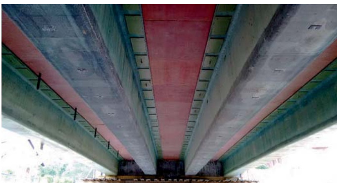
Fot. 8. Kompozytowe deskowanie tracone płyty pomostu pomiędzy dźwigarami
