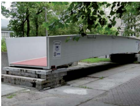
Fot. 11. Prototyp kładki pieszo-rowerowej FOBRIDGE o konstrukcji warstwowej (fot. J.Chróścielewski)
