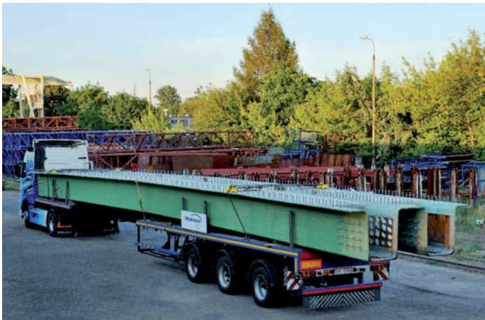
Fot. 6. Transport dźwigarów kompozytowych na plac budowy
