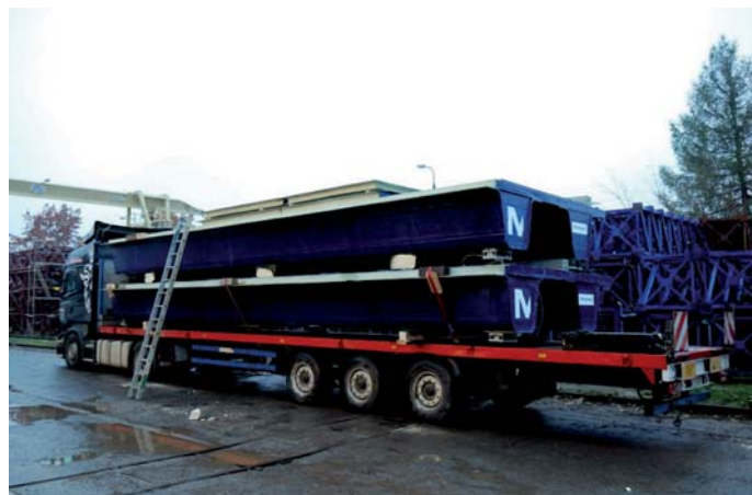
Fot. 1. Dwa tandemy przęsła mostu przygotowane do transportu na plac budowy (fot. T. Siwowski)
