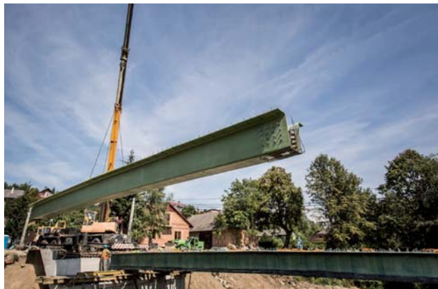
Fot. 7. Dźwigary kompozytowe na placu montażowym oraz montaż dźwigarów na podpory
