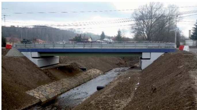
Fot. 10. Most drogowy o konstrukcji hybrydowej kompozytowo-betonowej w Błażowej
