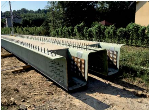
Fot. 7. Dźwigary kompozytowe na placu montażowym oraz montaż dźwigarów na podpory
