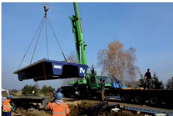
Fot. 2. Montaż tandemów przęsa kompozytowego na podpory (fot. T. Siwowski)
