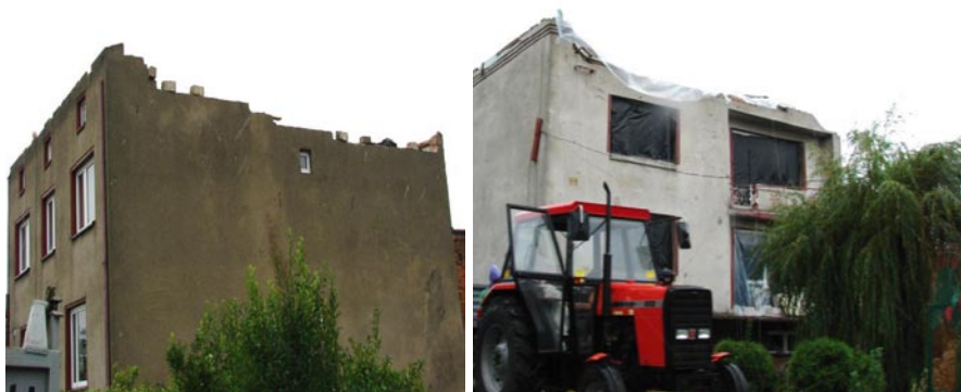
Rys. 1. Uszkodzenia powstałe na skutek działania silnych wiatrów
