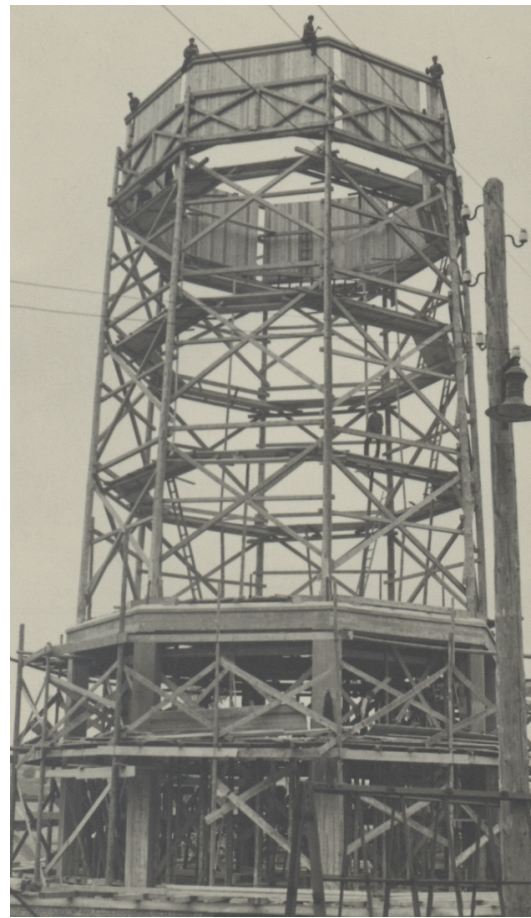
Rys. 4. Budowa drewnianej chłodni kominowej
