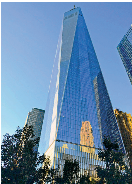
Rys. 5. Fasada budynku 1WTC, fot. wykonana przez autorów
