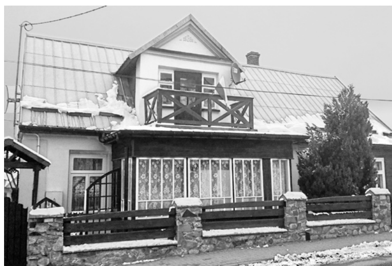
Ryc. 25. Dom o ścianach z dachówek w Czarnej Wsi Kościelnej przy ulicy Pięknej 76; fot. J. Ciecuch & P. Gołębiowski, 2016
