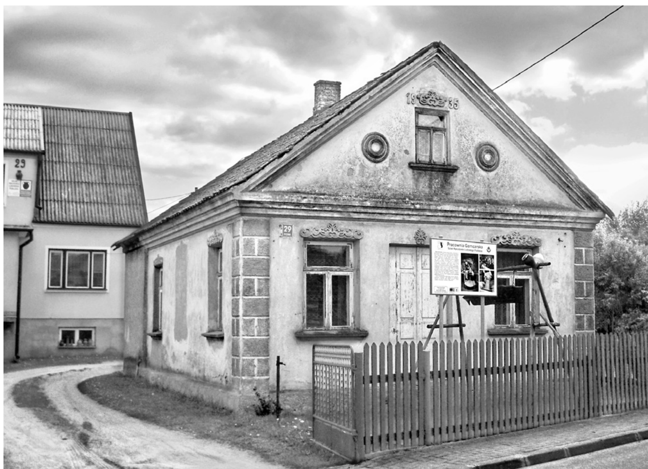
Ryc. 10. Pochodzący z 1935 roku dom o ścianach z dachówek w Czarnej Wsi Kościelnej przy ulicy Piękiej 29; fot. I. Horba (materiały archiwalne WA PB, 2012)
