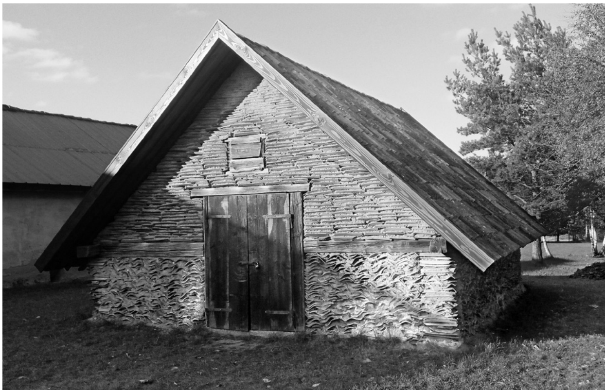
Ryc. 14. Piwnica gospodarcza wolno stojąca w Czarnej Wsi Kościelnej, ul. Piękna 60; fot. J. Ciecuch & P. Gołębiewski, 2016 Fig. 14. A detached storage cellar in Czarna Wieś Kościelna, 60 Piękna Str.; photo by J. Ciecuch & P. Gołębiewski, 2016
