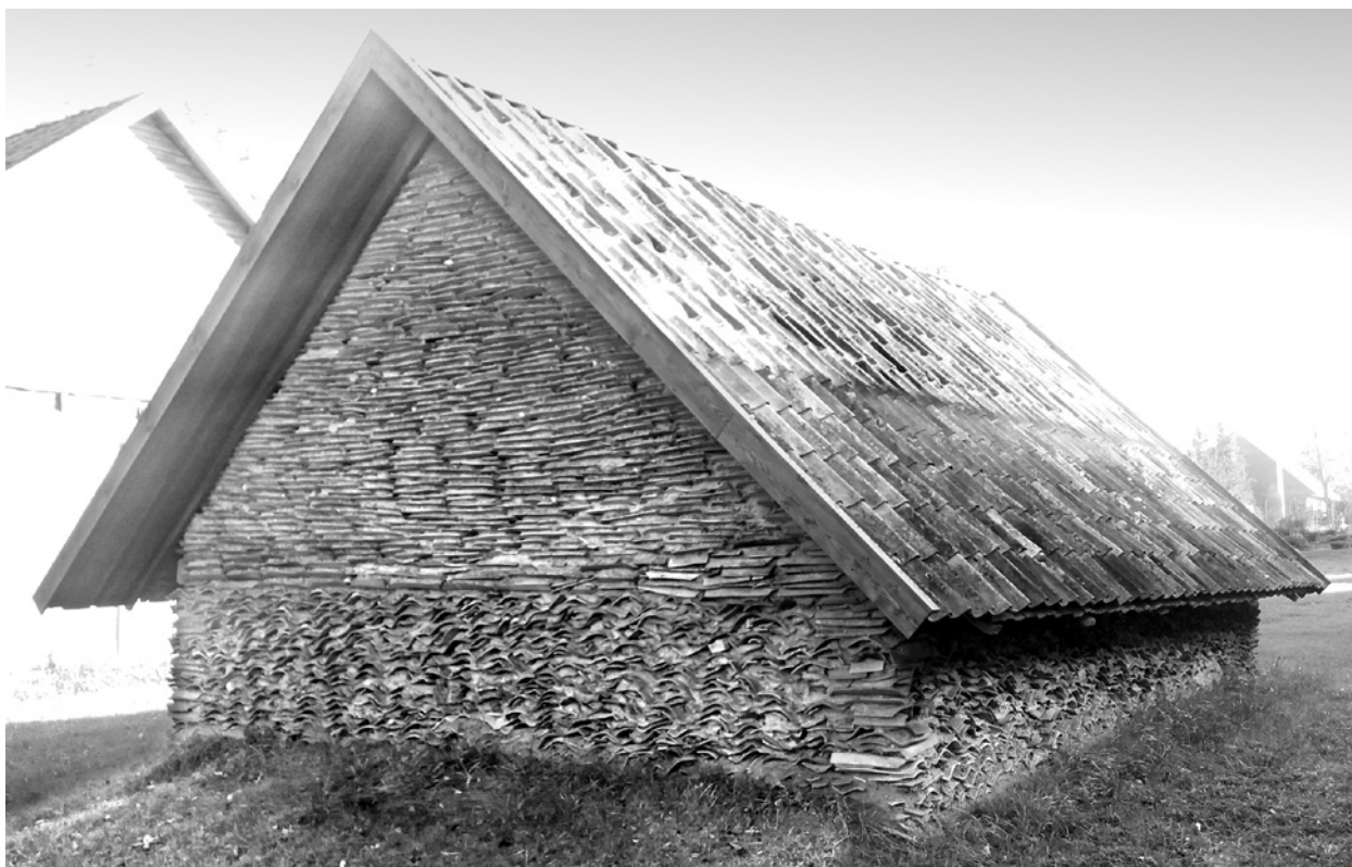
Ryc. 15. Piwnica gospodarcza w Czarnej Wsi Kościelnej przy ulicy Pięknej 60; fot. J. Ciecuch & P. Gołębiewski, 2016 Fig. 15. A detached storage cellar in Czarna Wieś Kościelna, 60 Piękna Str.; photo by J. Ciecuch & P. Gołębiewski, 2016
