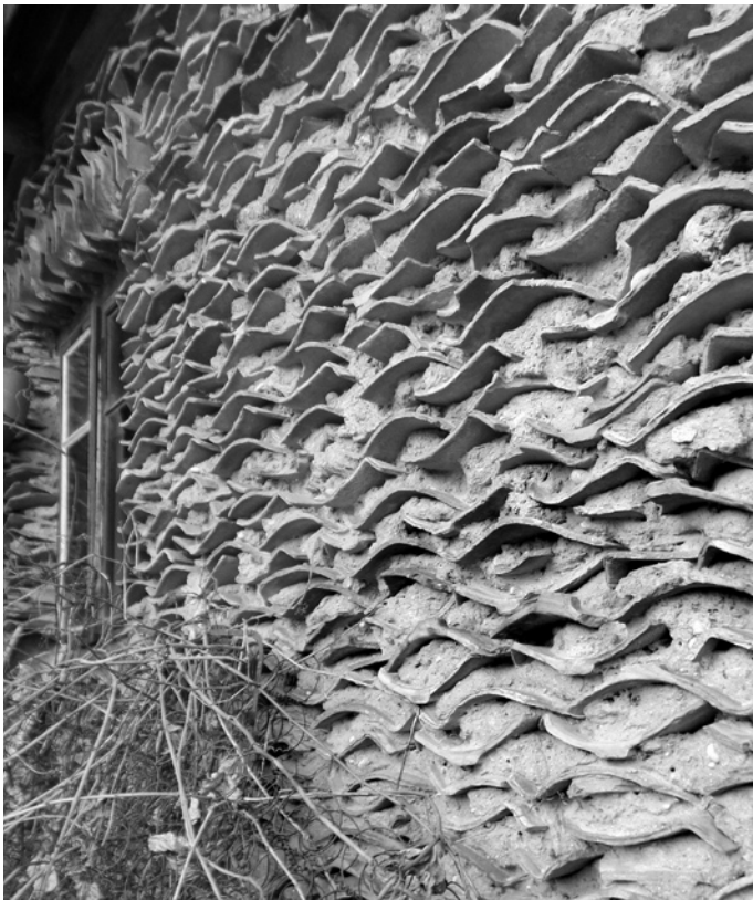
Ryc. 7. Fragment ściany budynku gospodarczego w Czarnej Wsi Kościelnej przy ulicy Pięknej 32a; fot. J. Ciecuch & P. Gołębiewski, 2016
