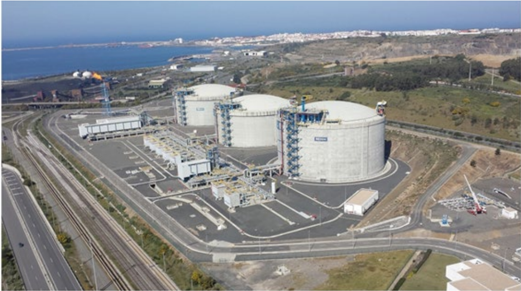
Fig. 4. LNG terminal in Sines
