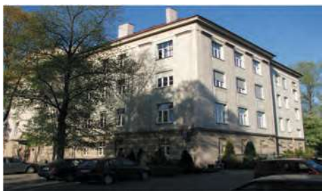
Foto. 5. Budynek dawnej bursy studenckiej na ul. Gramatyka – (fot. – B. Barchański 2018)
