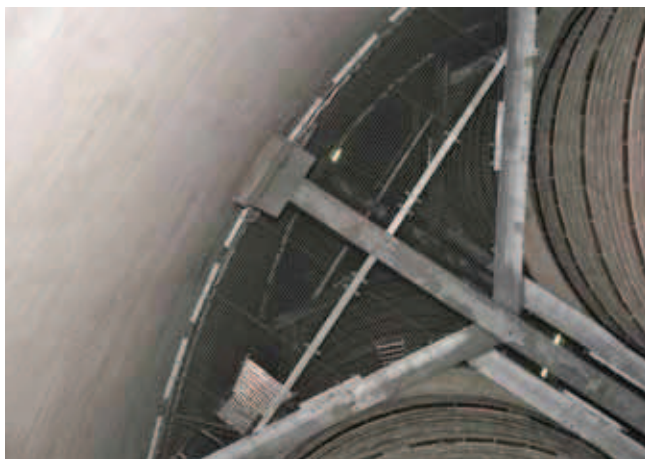
Rys. 3. Wewnętrzny strop stalowy, na którym spoczywają ceramiczne przewody spalin w kominie sześcioprzewodowym
