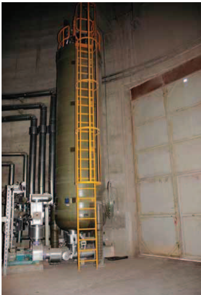
Rys. 7. Zbiornik kondensatu spalin w kominie
