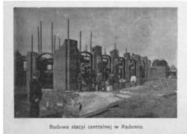
Rys. 2. Budowa centralnej stacji elektrycznej w Radomiu 1900 r.
