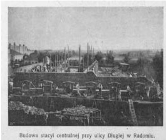
Rys. 1. Budowa centralnej stacji elektrycznej w Radomiu 1900 r.
