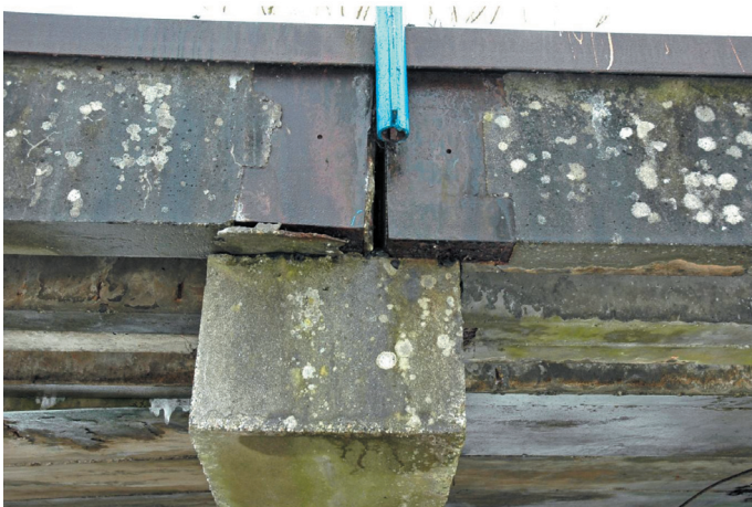
Fot. 2. Oparcie przęsła na oczepie filara 3 po stronie północnej
