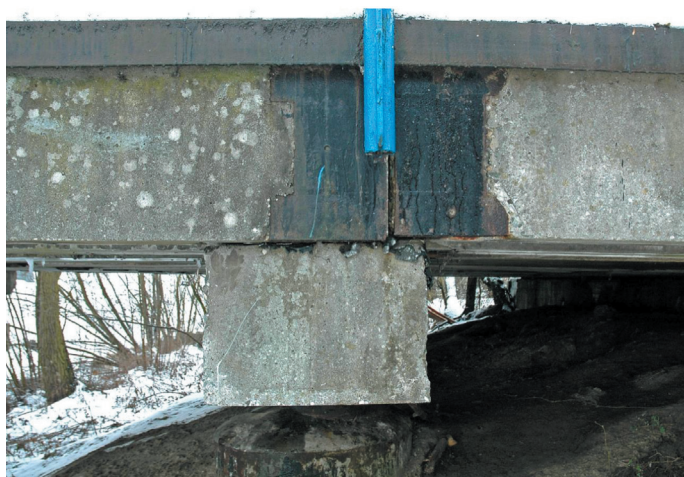
Fot. 3. Oparcie przęsła 2-3 oraz 1-2 na oczepie filara 2 po stronie północnej
