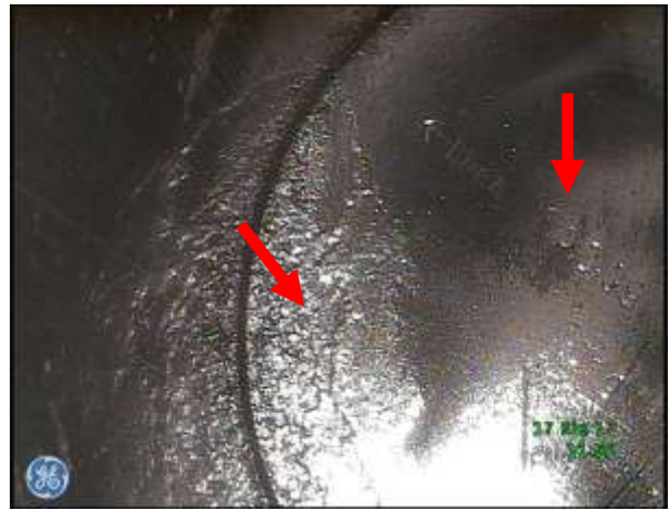
d) Denko tłoka – nieznaczne osady zanieczyszczeń, widoczny numer identyfikacyjny (katalogowy)
