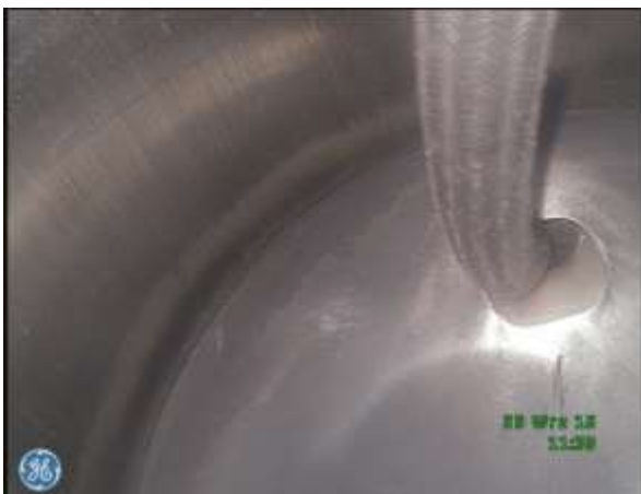
e) Dolna płyta głowicy – sonda inspekcyjna wprowadzona przez otwór po zdemontowanym wtryskiwaczu paliwa
