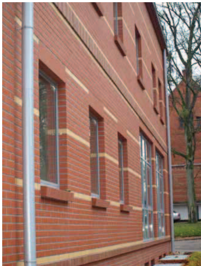
Rys. 3. Analizowana ściana zewnętrzna ze względu na współczynnik przenikania ciepła (pierwszy filarek od lewej). Z prawej strony parapetu widoczne wyjście termometrów do pomiaru temperatury ośrodka zewnętrznego (fot. archiwum autora)
