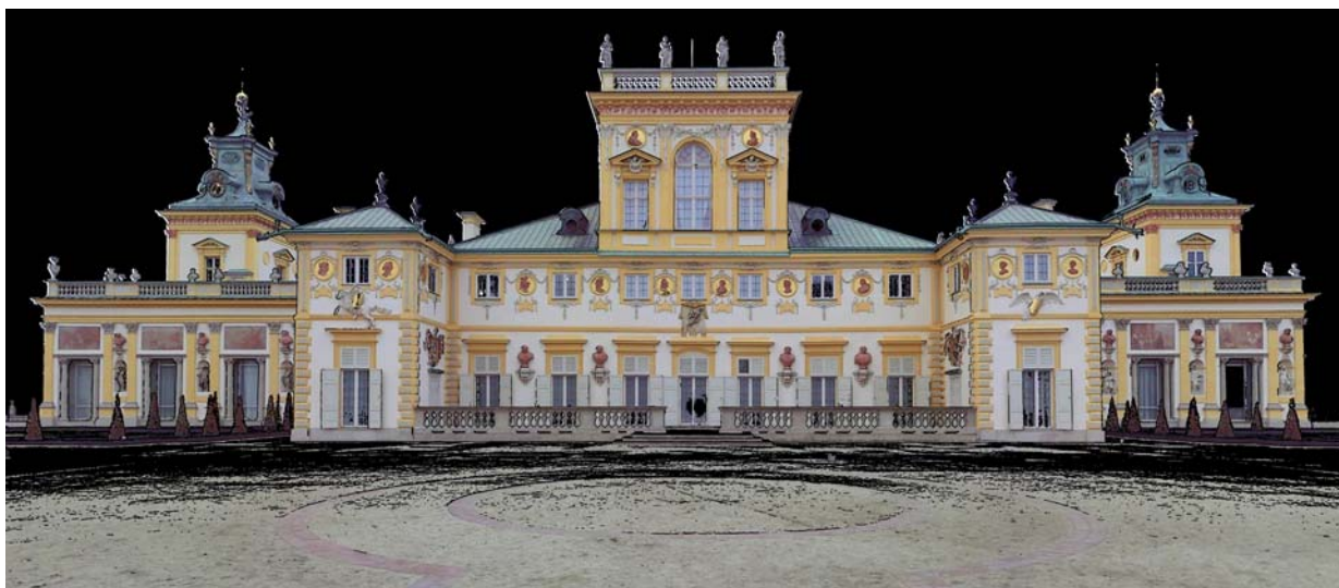
Ryc. 3. Muzeum Pałacu Króla Jana III w Wilanowie – fasada ogrodowa Pałacu. Wynik skanowania laserowego w formie kolorowej chmury punktów. Wyk. INCEDO3D Archiwum Muzeum Pałacu Króla Jana III w Wilanowie
