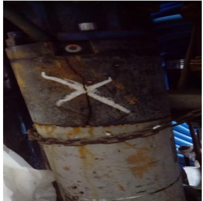
Rys 2. Pęknięcie obudowy agregatu głębinowego
