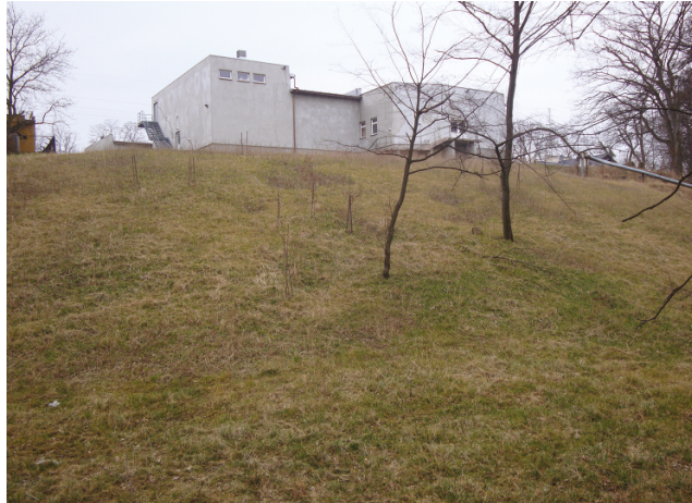
Fot. 10. Zbocze po rekultywacji Fot. 10. Slope after restoration
