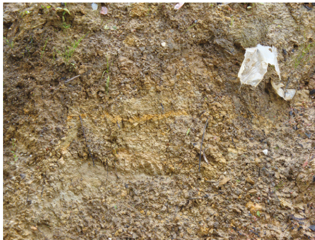
Fot. 6. Kolumwium - spękania w glinie pylastej Fot. 6. Colluvium – fissures in silt
