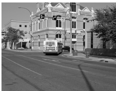
Fot. 8. Winnipeg, skrzyżowanie z dopuszczeniem skręcania w prawo (poza okresem pon.–pt. w godz. 7.00–17.30) przy nadawanym sygnale czerwonym, z dwoma pasami dla skręcających w prawo
