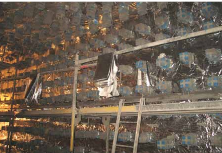
Rys.9. Komora spalania – etap montażu wyłożenia ogniotrwałego
