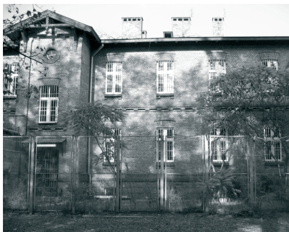
Rys. 1. Jeden z segmentów badanego obiektu – elewacja południowa [6].
