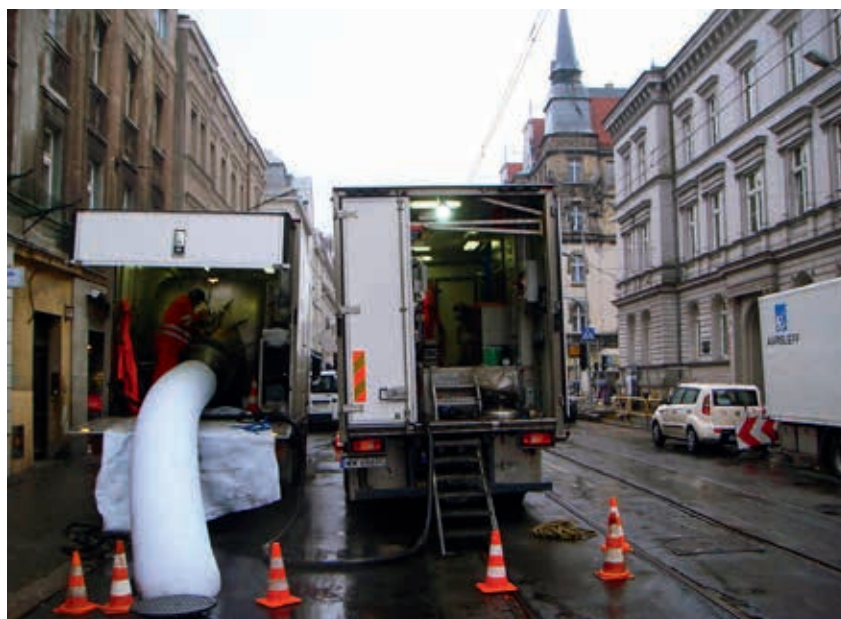
Instalacja prelinera
