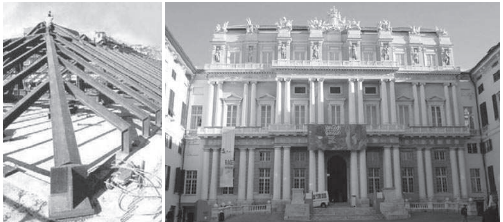
Rys. 6. Pałac księżcy w Genui, po lewej – stalowa konstrukcja więźby dachowej, po prawej – fasada obiektu, źródło: [W4], [W5]
