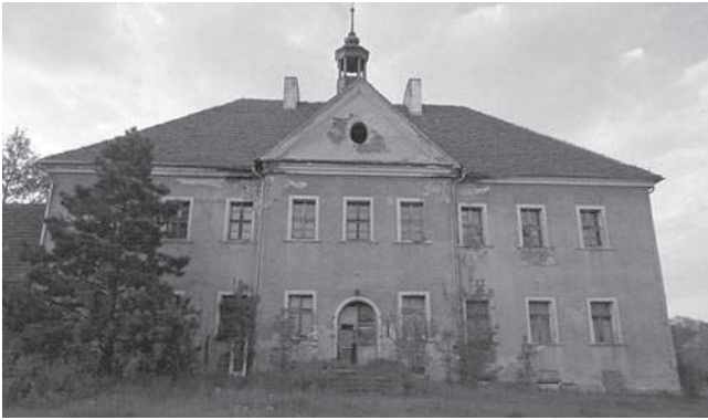
Rys. 12. Fasada obiektu, widok od strony południowej, źródło: fotografia własna
