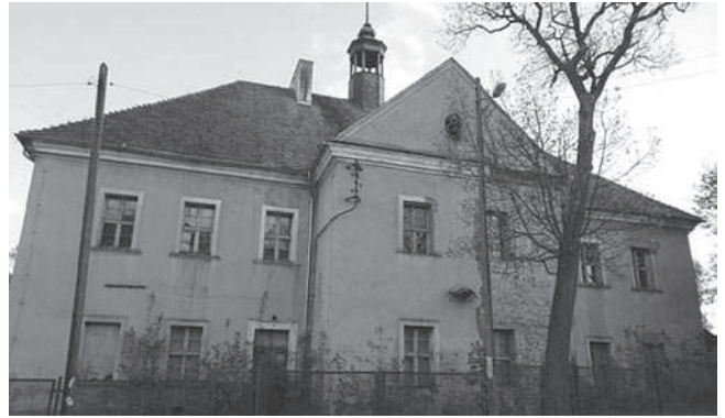
Rys. 13. Fasada obiektu wzbogacona o ryzalit, widok od strony północnej, źródło: fotografia własna
