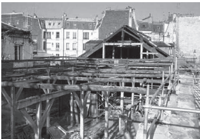
Rys. 1. Drewniana konstrukcja klasztoru Bernardynów w fazie demontażu, źródło: [W1]
