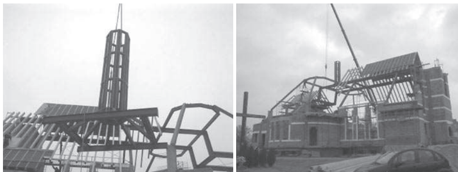
Rys. 8. Kościół w Bolechowie ze stalową więźbą dachową, źródło: [W7]
