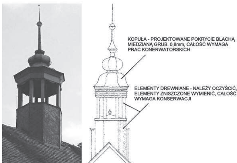
Rys. 16. Wieżyczka zwieńczająca dach pałacu, źródło: fotografia własna, rysunek z inwentaryzacji z roku 2013 [8]
