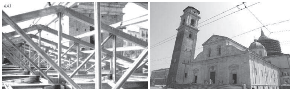
Rys. 7. Kościół Jana Battisty we Włoszech, po lewej – stalowe kratowe dźwigary dachowe, po prawej – fasada obiektu, źródło: [W5], [W6]
