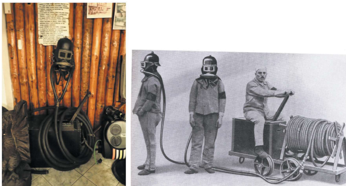
Rys. 3. Aparat węzowy Koenig w roku 1910 (zdjęcie - Sala Tradycji OSRG Jaworzno)
